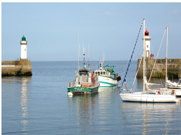
Fanali di entrata del porto: (visti da terra) Fanale verde a SIN e rosso a DR.
